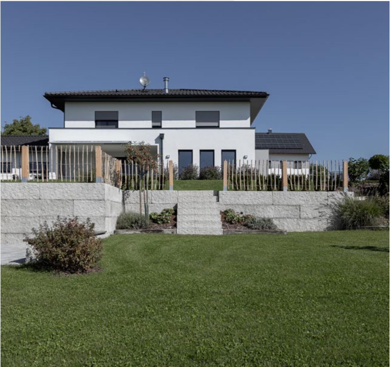
BigBLOCK Stützwandsystem aus B5 Beton
